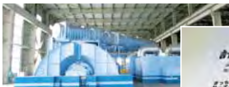
蒸気タービン発電機
